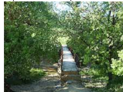
Ouvrage d'art lié aux canaux d'irrigation, Manosque.
