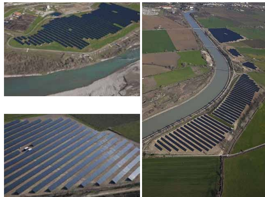
Les parcs photovoltaïques de Sainte-Tulle et de Manosque
